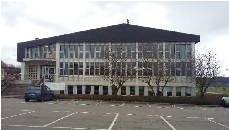
Façade vitrée côté est, présentant des bétons en bon état
