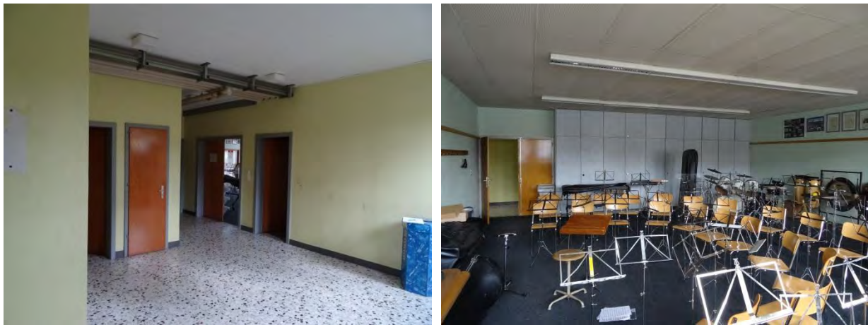
Couloirs du rez inférieur et salle de musique, revêtement de sol, plâtrerie et faux-plafonds en bon état
