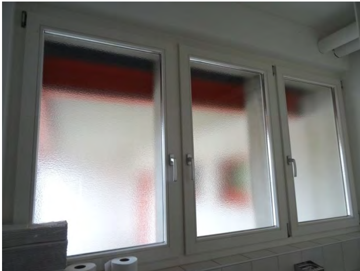
Fenêtres du local sanitaire du rez supérieur, en bon état
