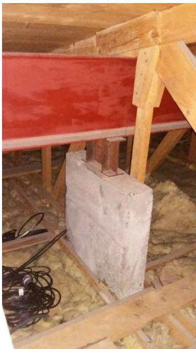
Toiture avec des fermes triangulées en bois, reposant sur des profilés métalliques – structure en bon état
