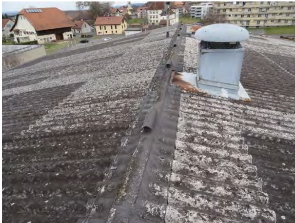
Couverture en plaque eternit ondulé fortement usé avec fixations en mauvais état
