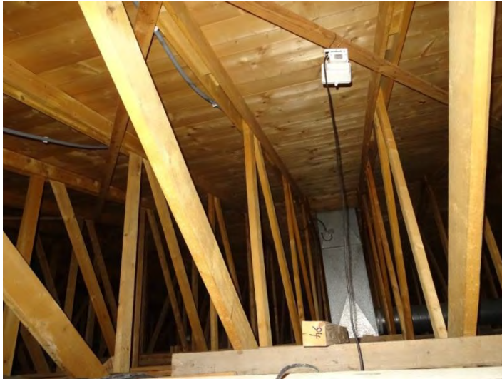
Fermettes triangulées et lambrissage
