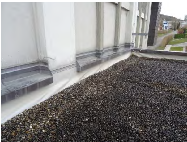
Toiture plate liaison, étanchéité de type Sarnafil en très mauvais état
